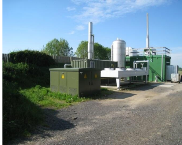
Heizhütte Klinkrade (Foto M.Wulf)
