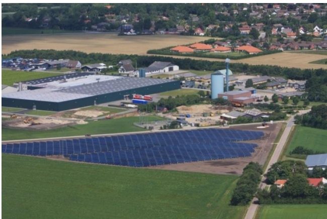
Thermische Solaranlage Gram , im Hintergrund die Industrieanlage, deren Dach statisch nicht geeignet war, rechts davon das BHKW-Gebäude mit Wärmespeicher, in der Mitte das bestehende Solarkollektorfeld, im Vordergrund ein Teil der Ausbaufäche für die Erweiterung der Solarthermieanlage sowie den Erdbeckenspeicher (Bild: Gram-fjernvarme)
